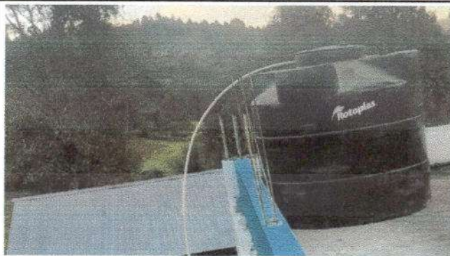
Foto 3: Sustitución depósito de agua
