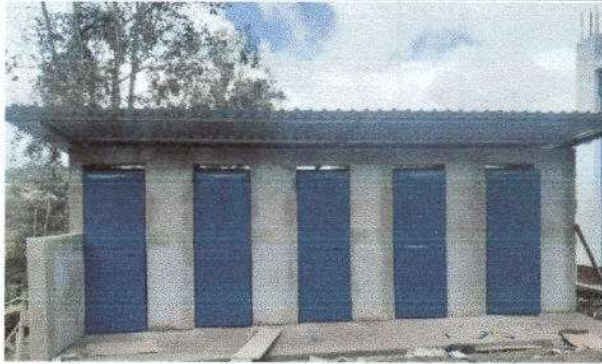
Foto1: Sustitución de puertas de los baños
