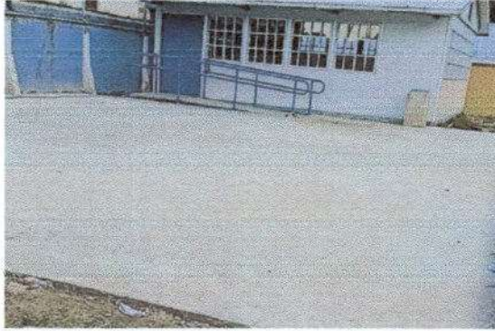
Foto1: Sustitución de torta de concreto
