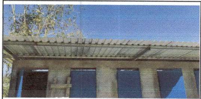
Foto 6: Sustitución de lamina por lamina troquelada aluzinc calibre 26
