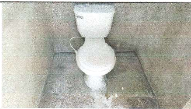
Foto 5: Sustitución de inodoros y sus accesorios
