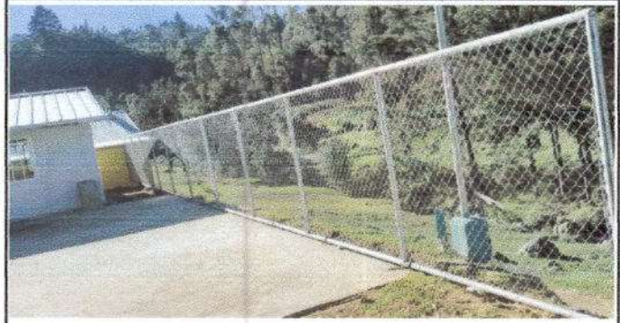
Foto 2: Reparación de muro perimetral
