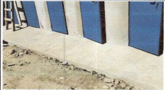
Foto 2: Sustitución piso de concreto en baños
